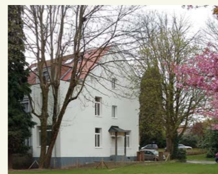
Allée Jacques Wiener 11: logement 4 chambres pour les revenus moyens, rénové en basse énergie
