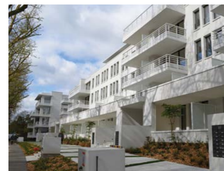
Le projet « Twice » , au coin du boulevard du Souverain et de l'avenue de la Fauconnerie, dont le chantier se termine, comprend 78 logements.
