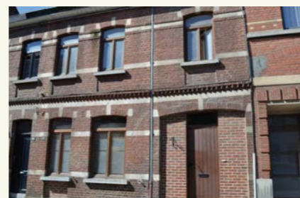
Chaussée de La Hulpe 335-337 : logement pour personnes à mobilité réduite, 1 chambre
