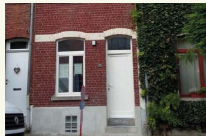
Chaussée de La Hulpe 521 : logement social, 2 chambres, rénové en basse énergie
