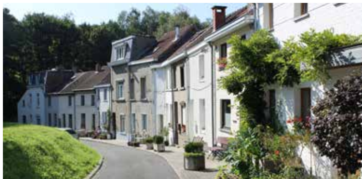
Bâti rénové du Heiligenborre au Coin du Balai
