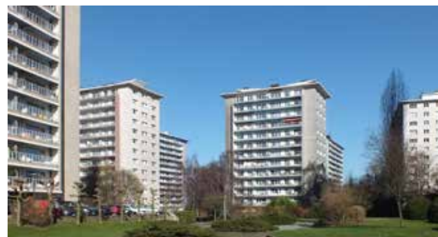
La Héronnière, bâtiments Etrimo construits au milieu des années '60
