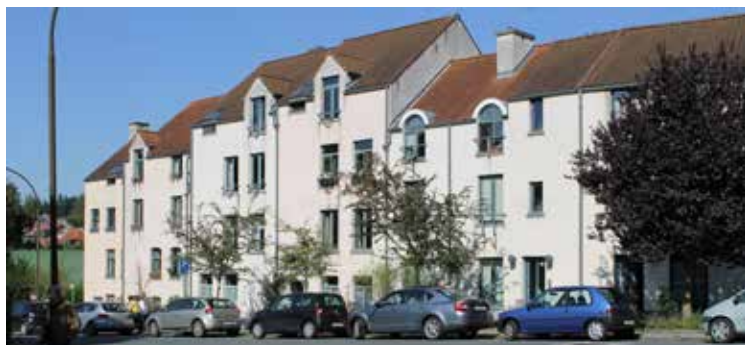
Constructions récentes du Heiligenborre, (e.a. logements seniors du CPAS)
