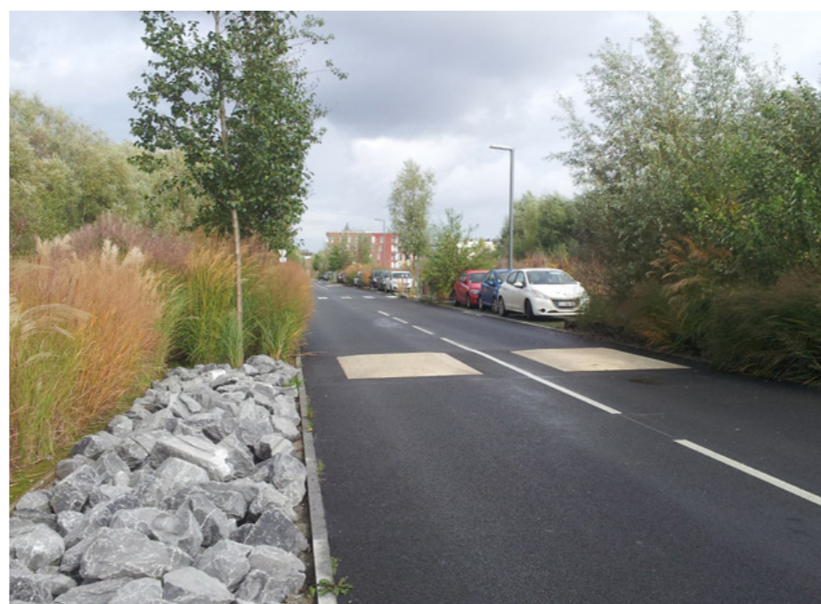
Rives de la Haute Deule, Lille, Atelier Bruel Delmar Gestion des eaux pluviales en voirie
