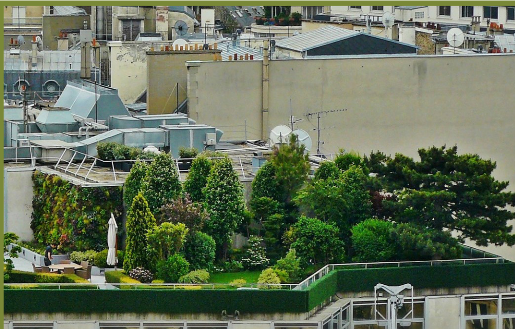
verdurisation des toitures
