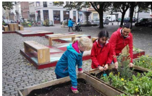
Construction de mobilier sur la place de Ninove - Cakri (2015)
